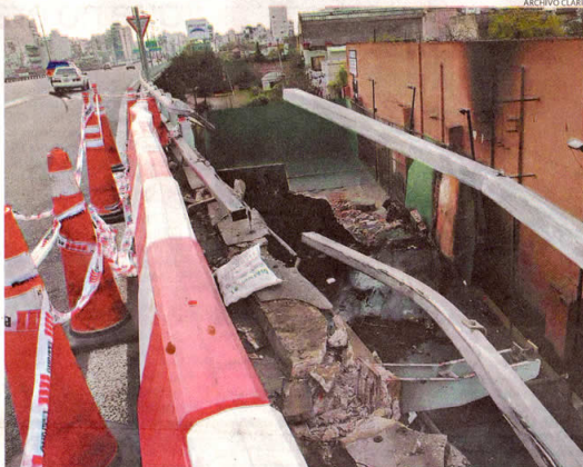
VESTIGIOS. EN LA AU 25 Y PICHINCHA, EL GUARDARRAIL ROTO Y LA CAMIONETA DADA VUELTA E INCENDIADA AQUEL DÍA.
